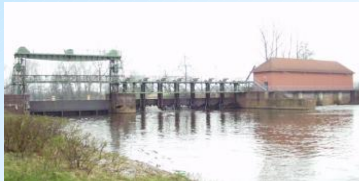
Unterstromige Ansicht der Wehranlage
